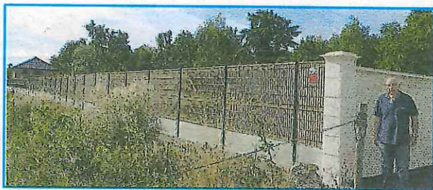
Thierry Herry, maire adjoint, devant une construction illégale.
